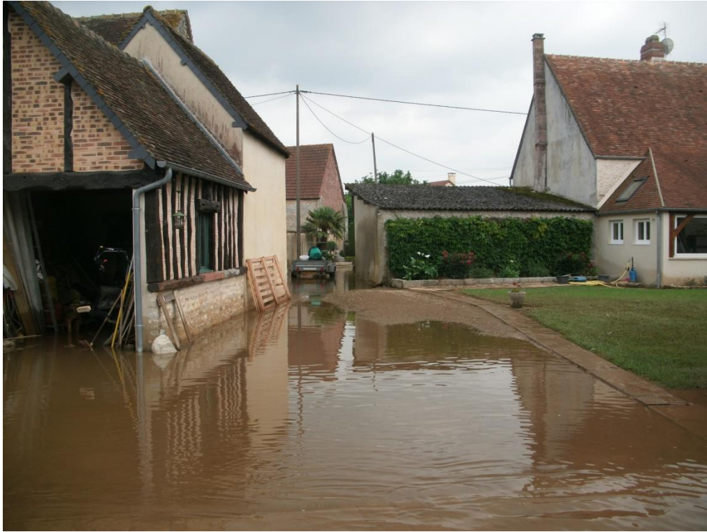
Une habitation et son garage inondés lors de la crue du 12 juin. A Belfonds
